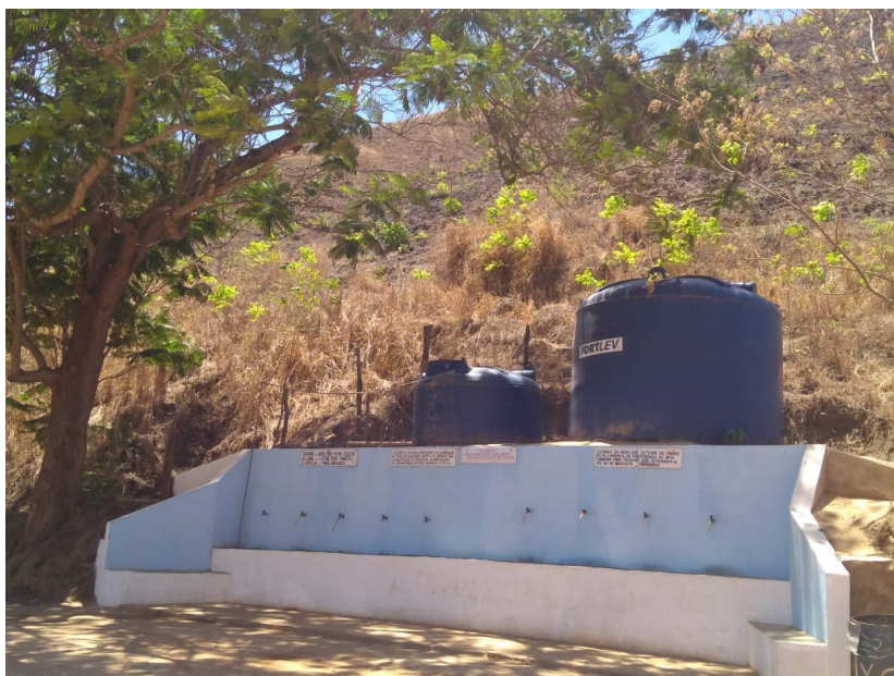
Figura 26 — Minas de água com construção coletiva para a captação de água da população no município de Galiléia
